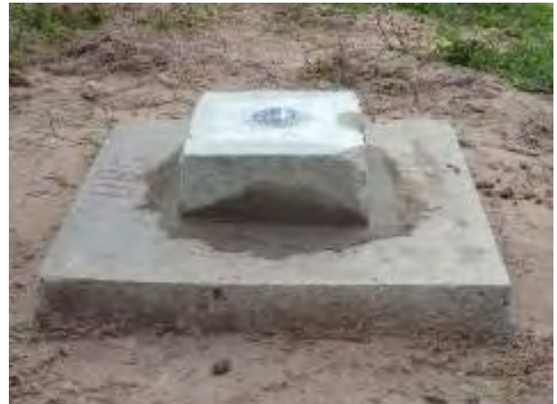
Figura 04 Exemplo de vértice de apoio básico com coleta de coordenadas GPS.
